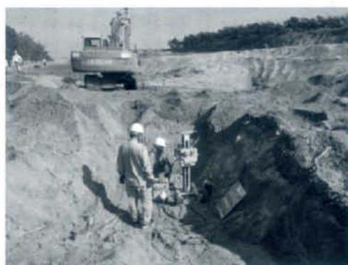
▲写真-2 スウェーデン式サウンディング試験状況
