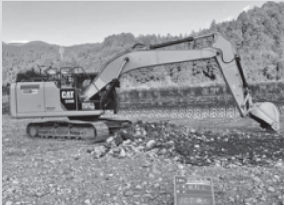
ICT建機による自動制御施工
