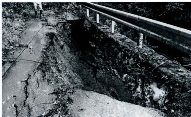
▲また各所で道路上への土砂の崩落や路肩の陥没などの被害も発生し、地元の建設業は早期の復旧に向けてもその力を発揮した。
