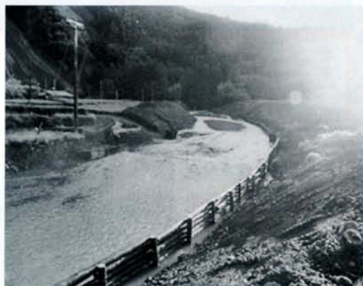
▲応急工事の完了により、仮排水路への通水が始まった。
