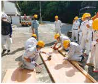
型枠加工・組立
