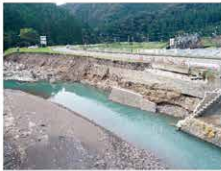
二俣川(只来)護岸崩壊補修
