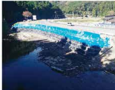
二俣川(只来)護岸崩壊補修
